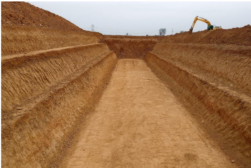
شکل ۵-۲ اجرای شیب پایدار با رعایت زوایا و عمق مناسب
