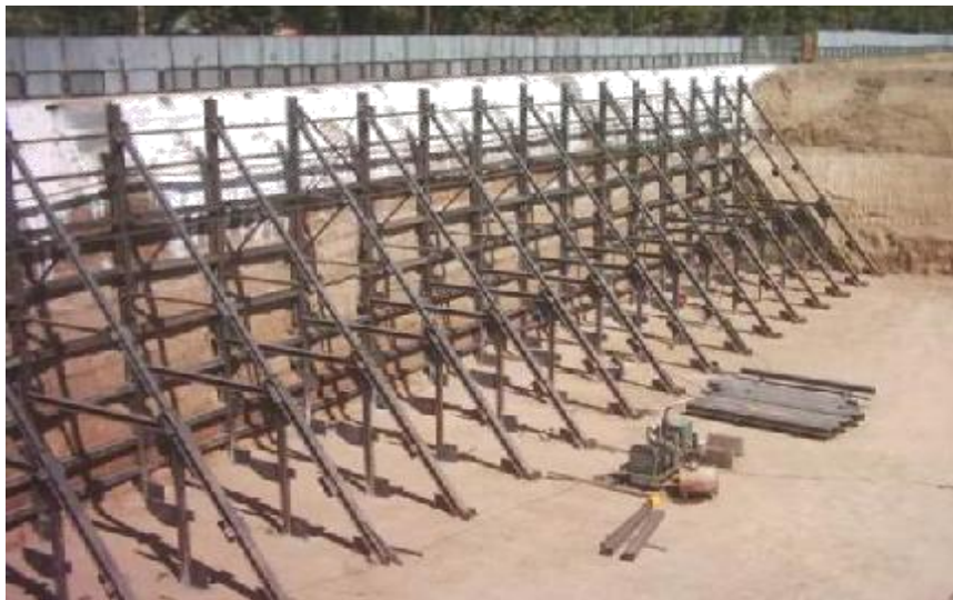
شکل ۳-۱۲. سازه نگهدار موقت از نوع خرپایی
