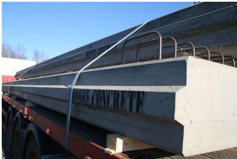
شکل ۳-۱۶. انتقال قطعات پیش ساخته به محل کارگاه
