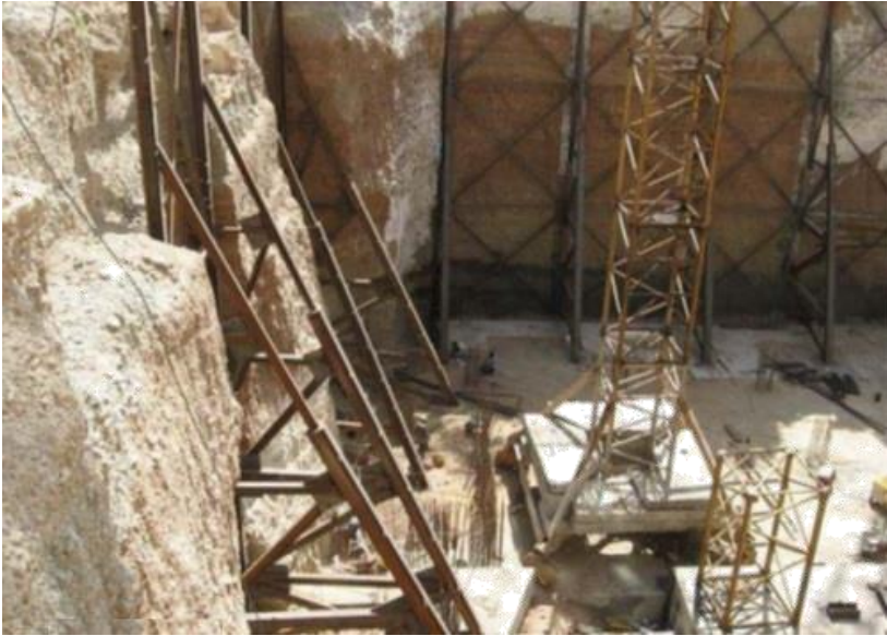
شکل ۵-۷. پایدارسازی گود به روش اجرای خرپا
