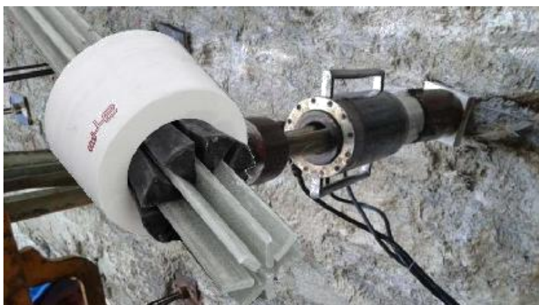
شکل ۵-۵. اجرای گودبرداری به روش انکراژ
