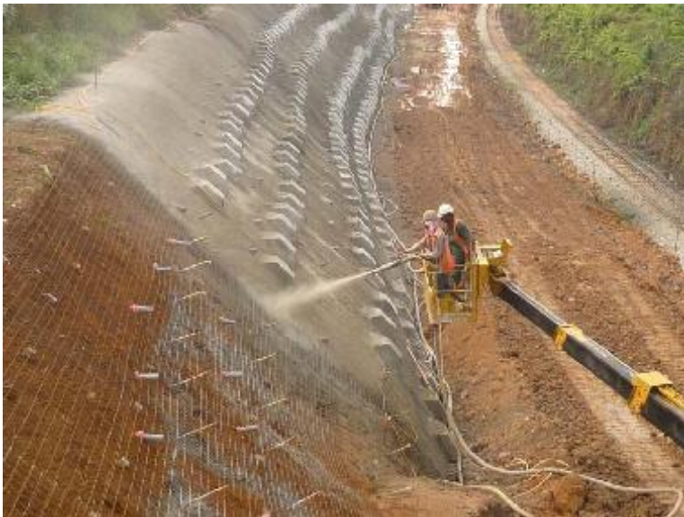
شکل ۵-۳. اجرای عملیات پایدارسازی گود با استفاده از روش میخ کوبی
