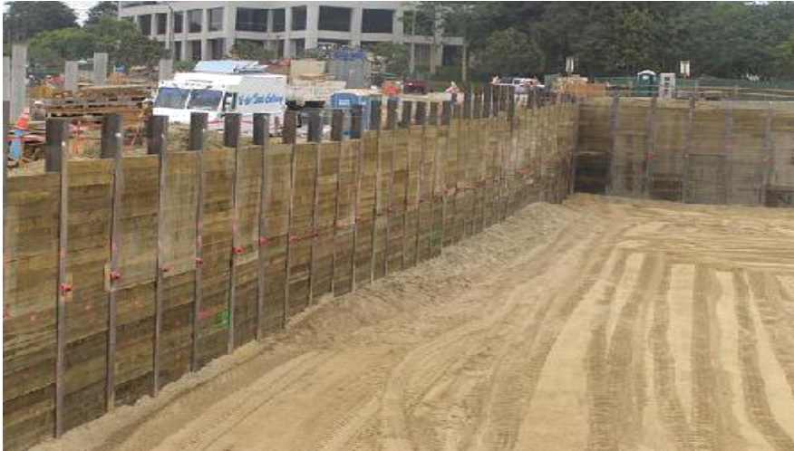
شکل ۵-۶. تصویر دیوار برلنی اجرا شده در یک پروژه
