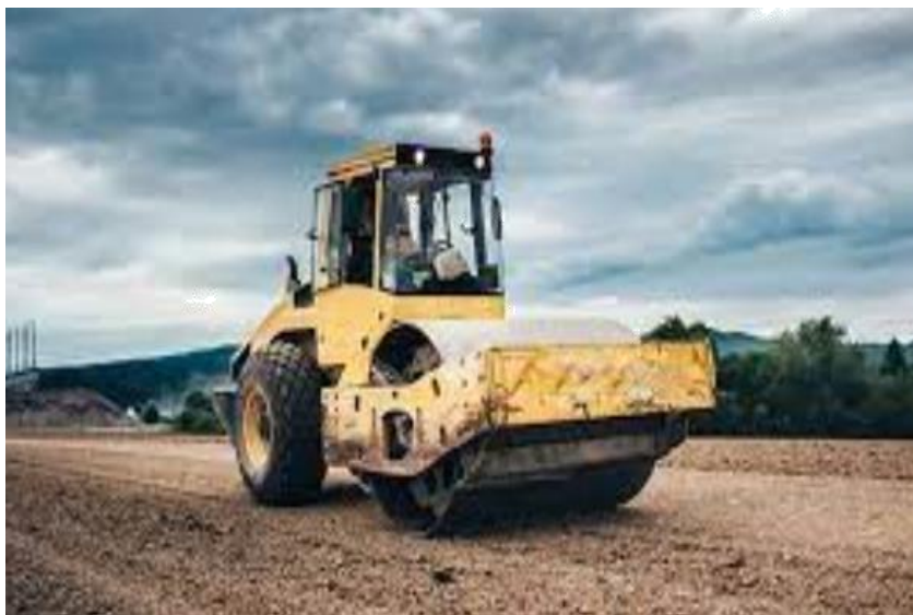
شکل ۱-۱۰. استفاده از غلتک به منظور افزایش وزن مخصوص خاک و تراکم خاک
