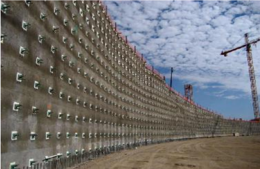
ب) اجرای شاتکریت روی شبکه اجرا شده
