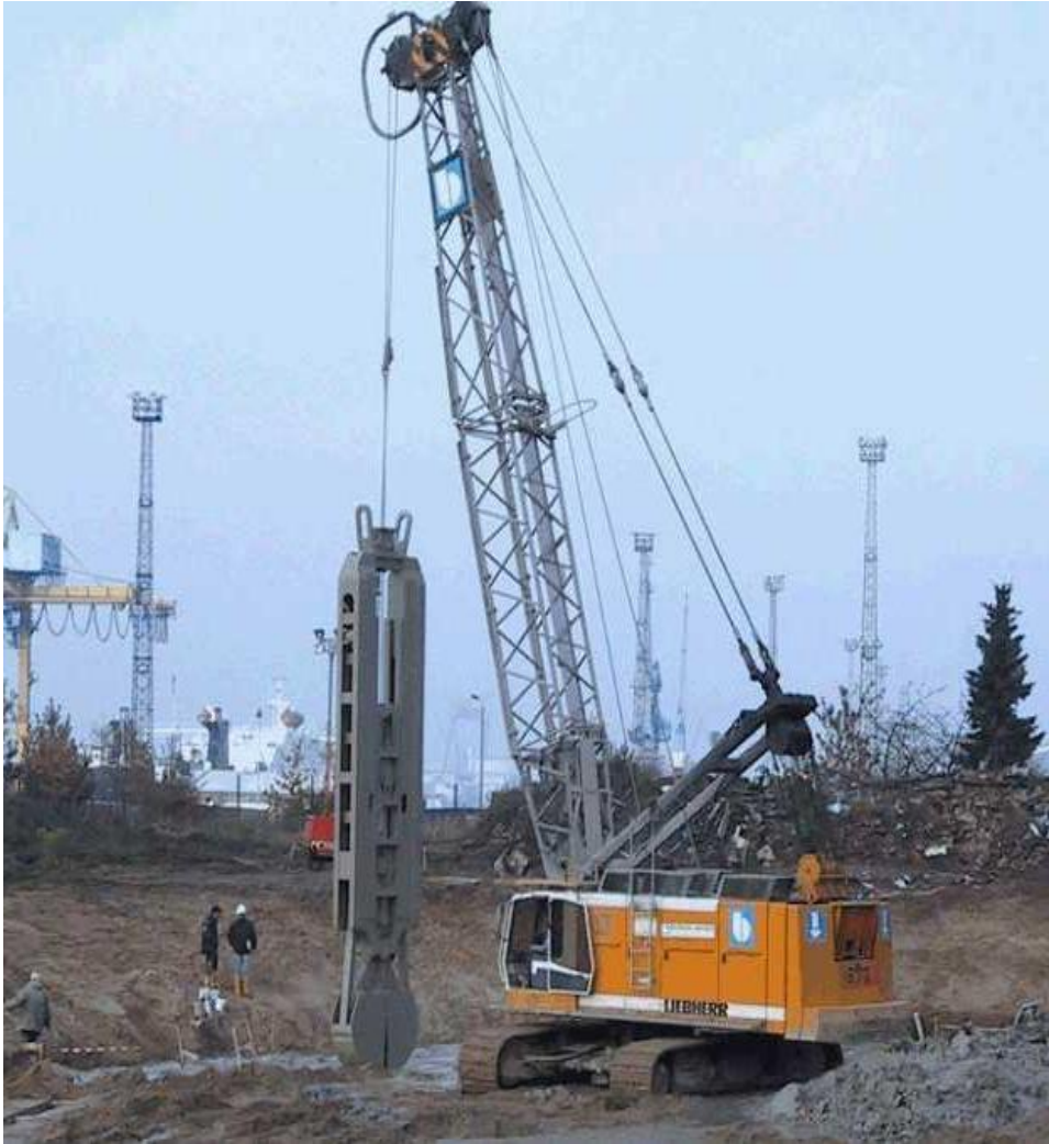
الف) دستگاه مخصوص برش خاک
