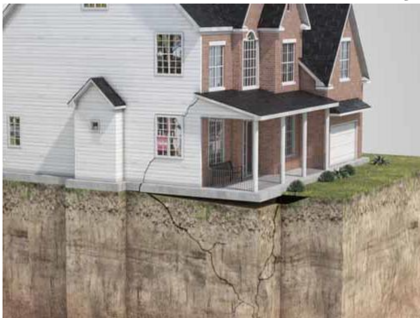
شکل ۱-۶. نمایی از ساختمانی در مجاورت گودبرداری و آسیب ناشی از نشست خاک
