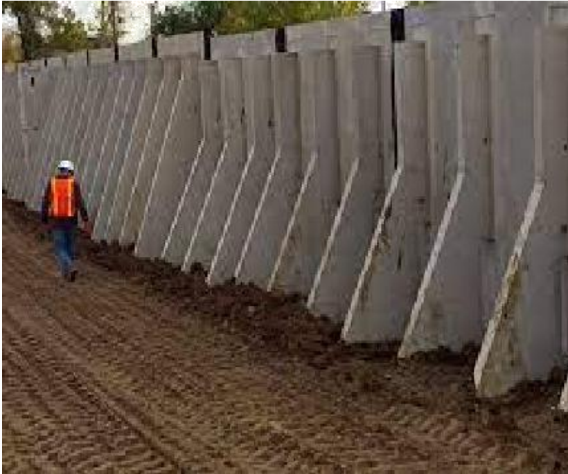
شکل ۴-۹. اجرای دیوار حائل پشت بند دار
