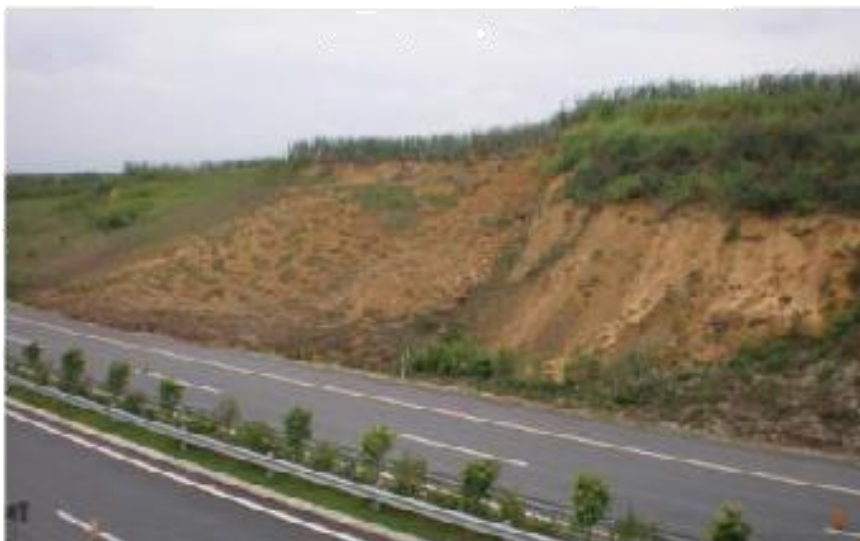
شکل ۵. ۱. استفاده از شیب پایدار در اجرای گودبرداری
