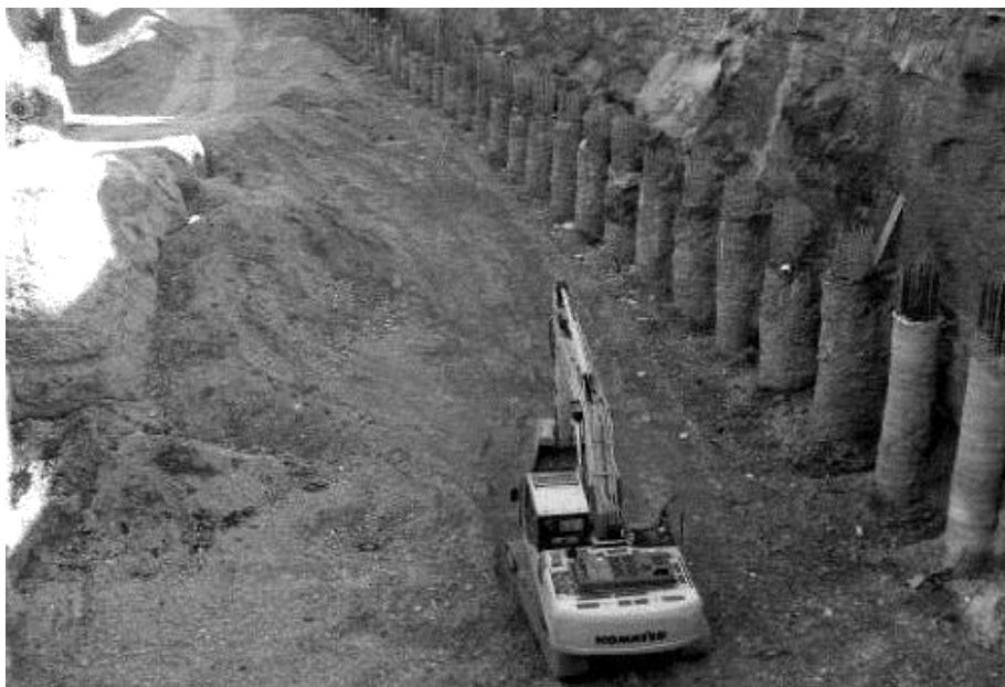
شکل ۳-۵. پایداری‌سازی گود به روش اجرای شمع
