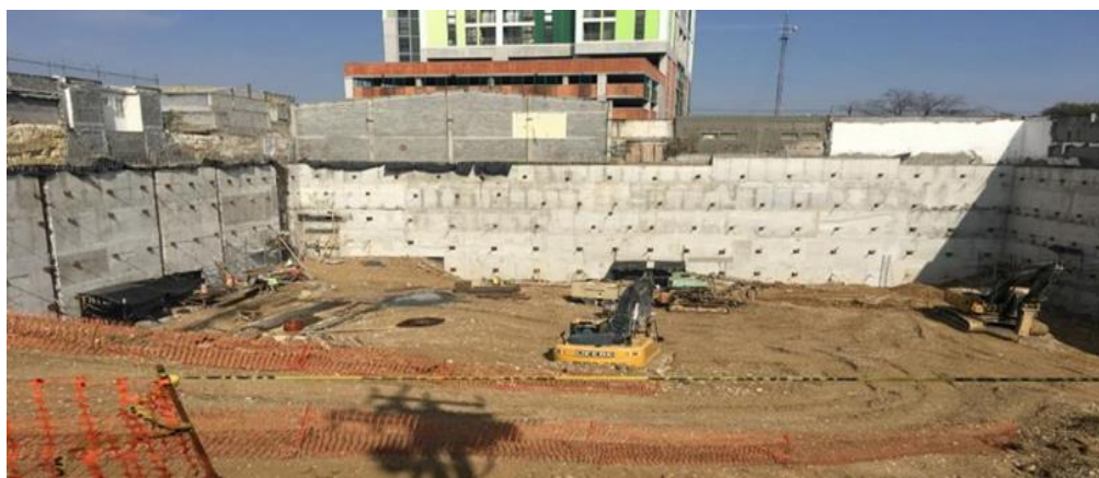
شکل ۱-۲. محل پروژه قبل و بعد از عملیات گودبرداری
