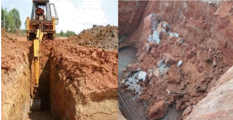
شکل ۱-۱۱. شکل اثر خاک محل در پایداری گود
