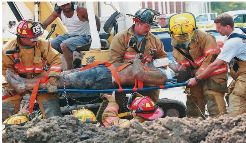
شکل ۱-۱۴. خسارت‌های جانی شدید ناشی از ریزش گود
