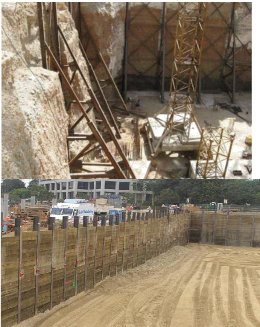
شکل ۵-۹. اجرای سپر به منظور پایداری گودبرداری
