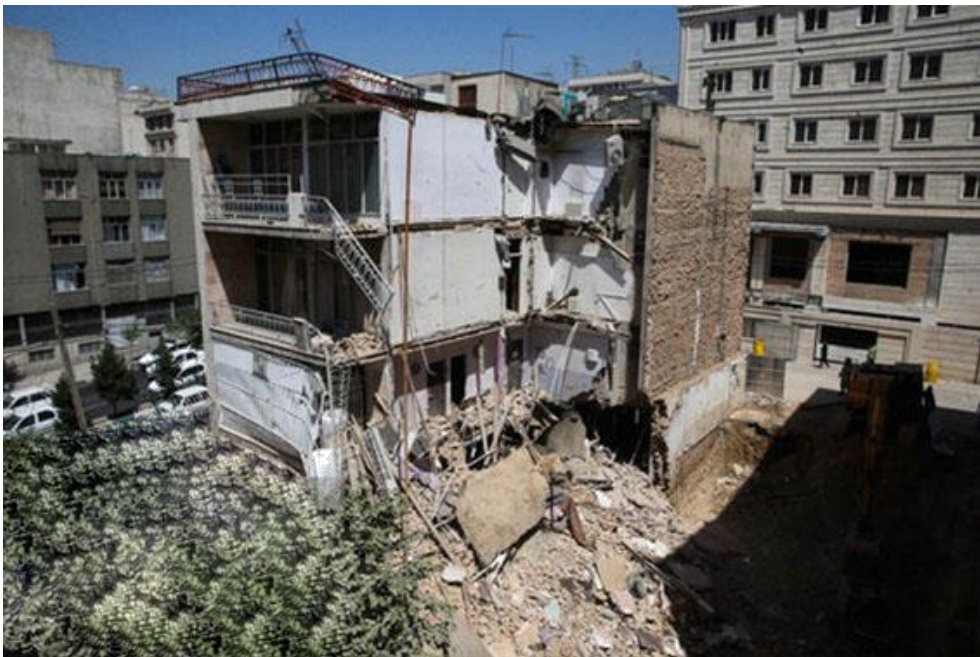
شکل ۶-۵. تصویری از ریزش ساختمان مسکونی در منطقه گیشا تهران
