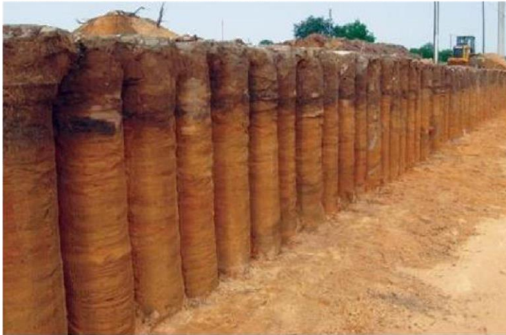
شکل ۴-۱. اجرای سازه نگهدارنده با استفاده از شمع
