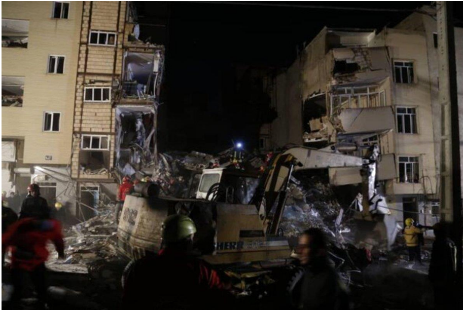
شکل ۶-۳. تصویری از ریزش ساختمان مسکونی مجاور گود در تبریز
