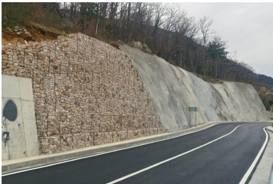
شکل ۴-۱۱. استفاده از گابیون در پایداری دیواره خاکبرداری
