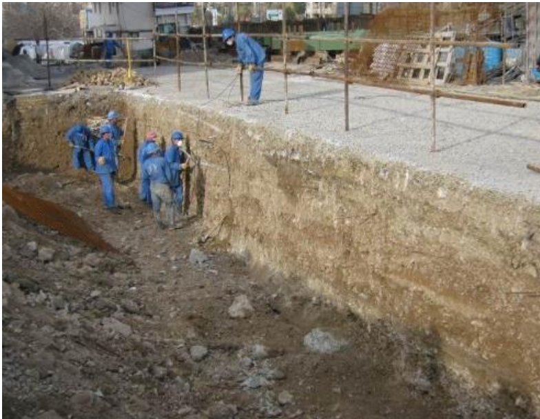
شکل ۱-۱۳. عمق پایدار گود
