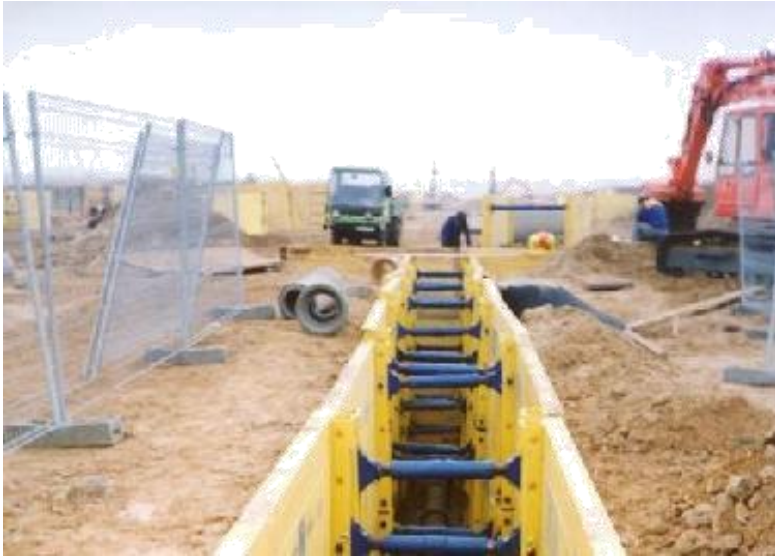
شکل ۵-۱۲. تصویر گودبرداری پایدار شده به روش مهار متقابل
