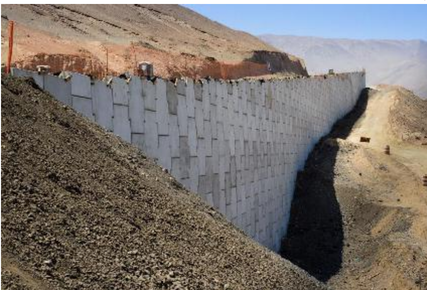
شکل ۴-۳. اجرای دیوار خاک مسلح با استفاده از تسمه
