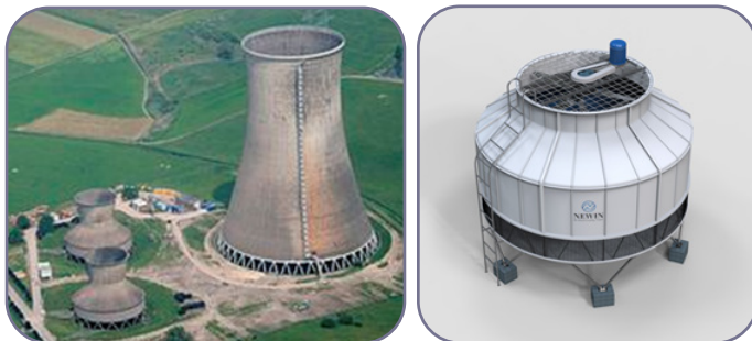
شکل ۹-۳. تصاویر واقعی دو نوع برج خنک کننده (برج دودکشی سمت چپ، برج جریان مختلف سمت راست)
